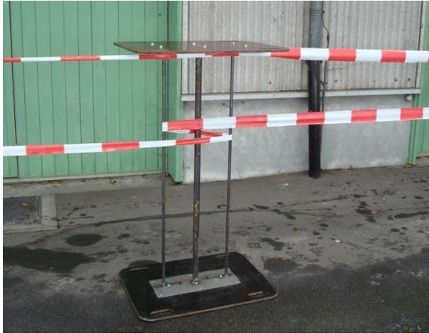
Die Haspel werden als Ständer für die Sicherung der Sperrzone verwendet.
