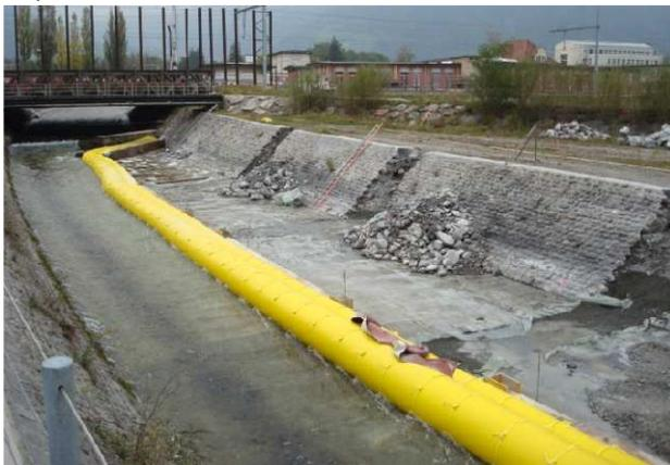
Im trocken gelegten Flussbett werden die Vorbereitungen für das Erstellen der Bohrpfähle gemacht.
