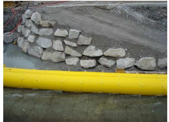
Damit mit dem schweren Bohrgerät ins Bachbett gefahren werden kann, wurde diese Rampe gebaut.
