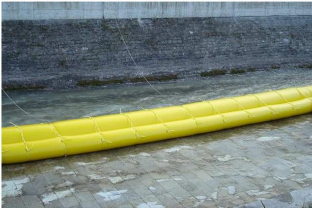
Nun sind beide Schläuche mit Wasser gefüllt. Der Fluss fließt nun in seinem neuen und schmaleren Bett. Die Fließgeschwindigkeit des Wassers beträgt ca. 6m/sec.
